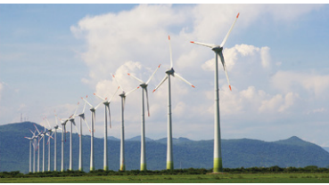
ブラジル工場で利用している風力発電(写真はイメージです)
