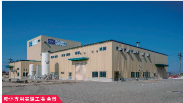
粉体専用実験工場 全景
