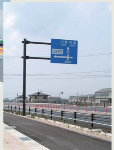
島根県松江市
