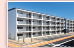
アルミ手摺施工例
